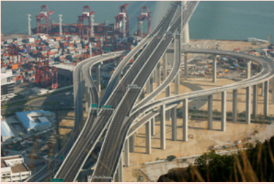
昂船洲大桥长1.3公里，中心跨距达1,018米。使用二维和三维有限元分析法进行基础建模，可以模拟与此类高桥相关的复杂荷载条件，例如，船舶冲击和地震地面振动。
