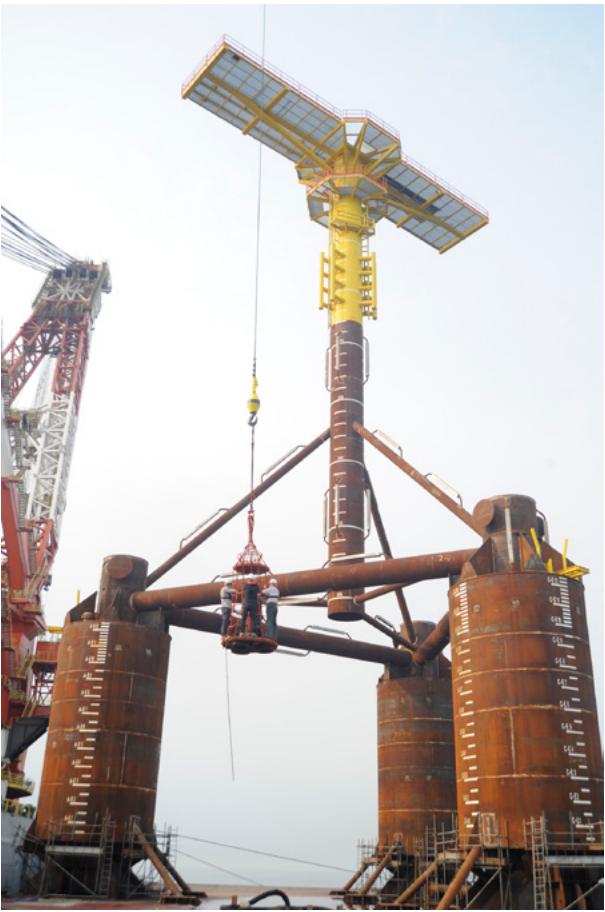
奥雅纳首创开发了吸力式桶形导管架结构设计, 基于项目现场和风电机的实际情况对至少两种风力涡轮发电机型号进行了综合负荷分析。
