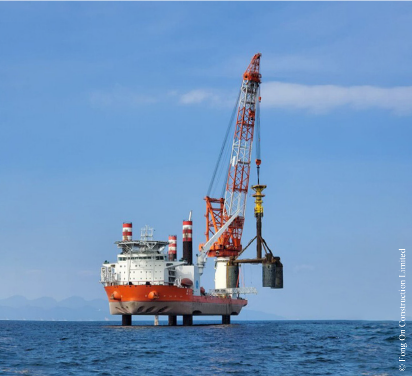
奥雅纳接受委托设计一个测风塔，用于测量风速和其他相关数据，并开创性地使用吸力式沉箱基础。这些工作旨在帮助中电确定大型风电场项目的可行性。
