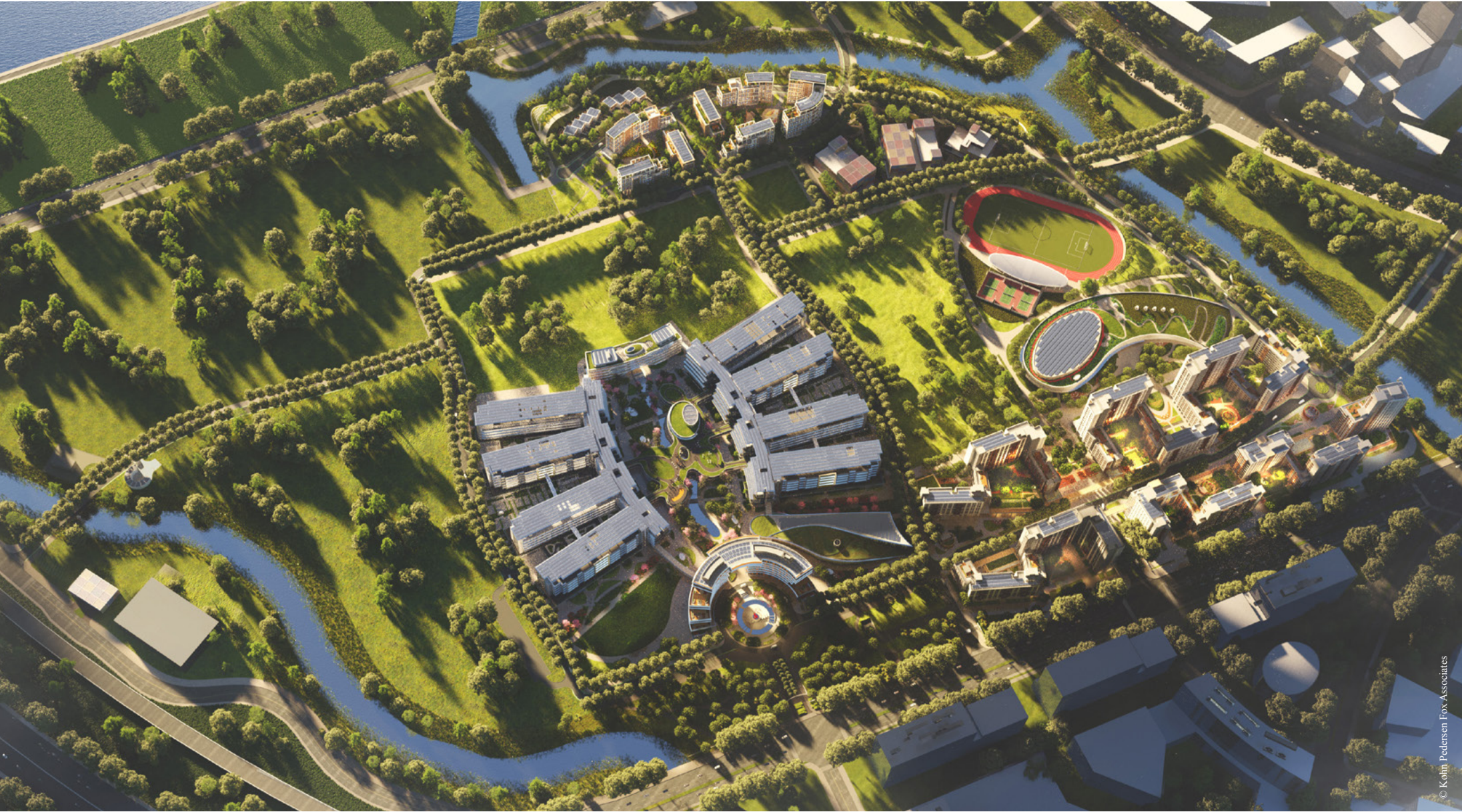
校园处于三水环绕的中心位置,通过利用雨水和洗涤水来实现“零水浪费”目标,同时最大限度地减少淡水消耗。
