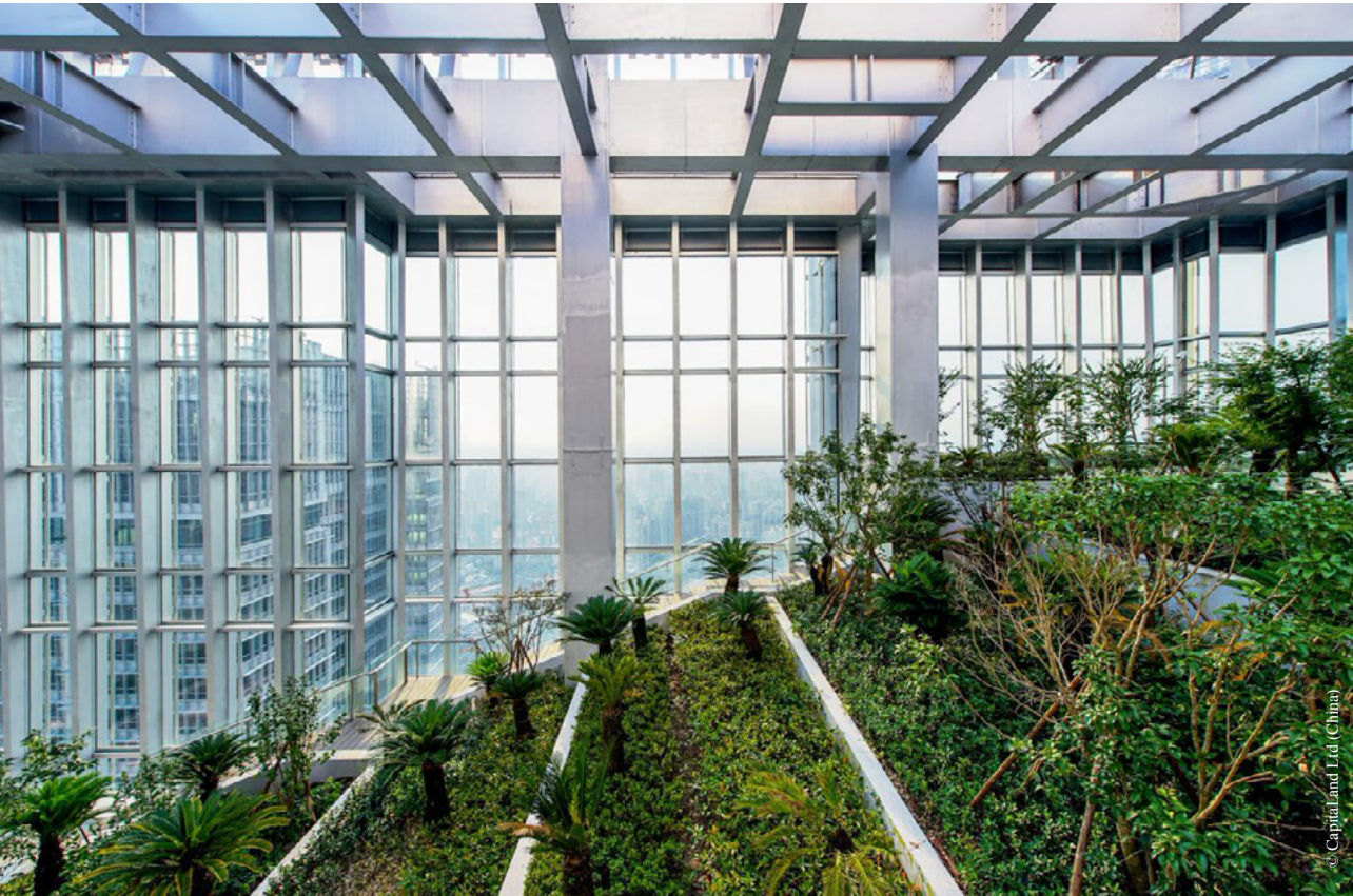
绿色屋顶利用715立方米的储水箱来收集和處理雨水，再用于灌溉、清潔和冷卻塔。这个过程通过减少径流来复制自然水文过程。
