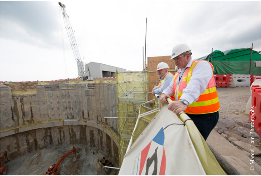
2015年，Peter Thompson(后)和Mark Wallace(前)实地考察屯门至赤腊角连接路北段的海底隧道段施工现场。
